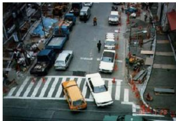
工事中のパティオ十番(1986年 山本仁壽)
