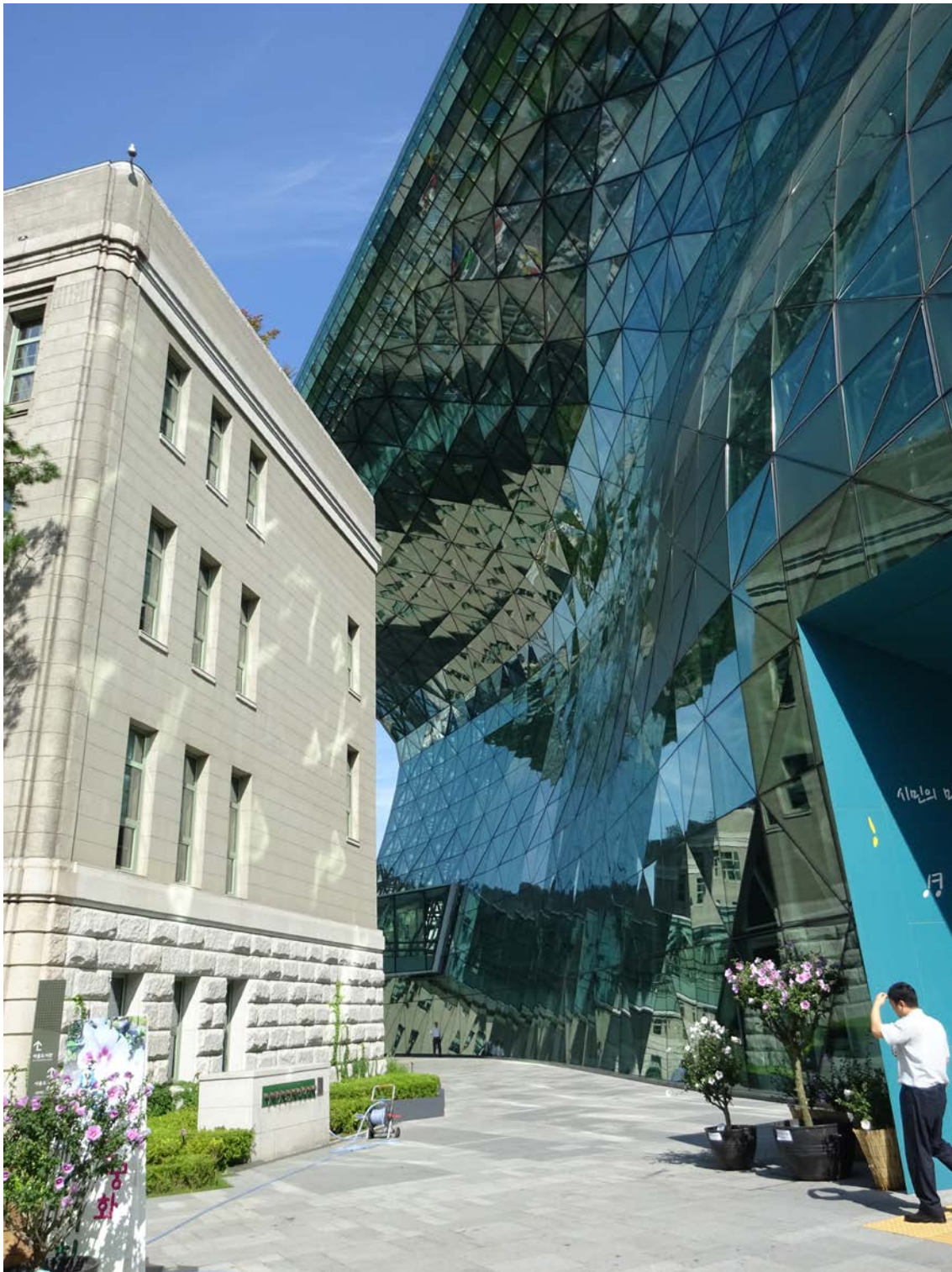
旧市庁舎の背後に迫りくる新市庁舎
